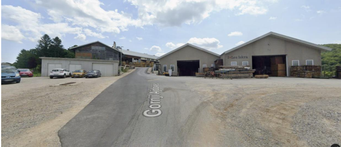
Pogled na obstoječo proizvodno halo (desno od ceste) in skladišča (levo od ceste) (Google Maps)
